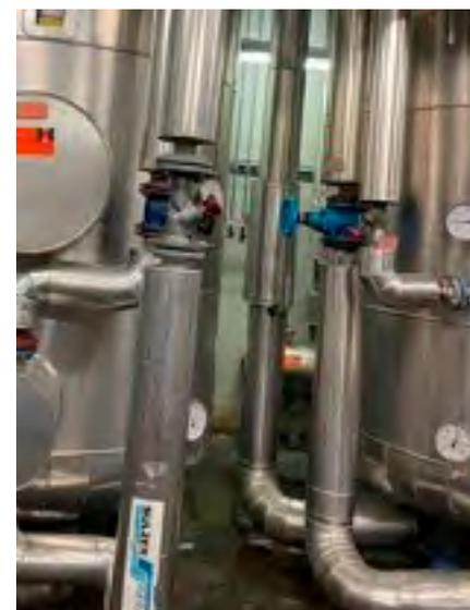
Wie in Wuppertal erfolgt die Lüftung sowie der Wasserkreislauf über Wärmetauscher. Das zu verwendende Wasser wird über getrennte Leitungen erwärmt und dadurch weniger stark erhitzt, um die Wunschtemperatur zu erreichen.
